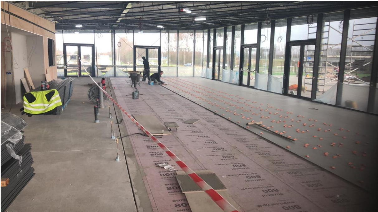
Foto tegelwerk kantine
